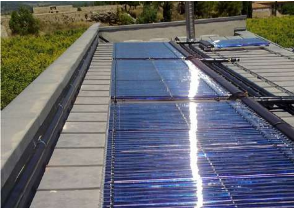
Teulada fotovoltaica al sostre del Palau de l'Abat del monestir de Poblet.
